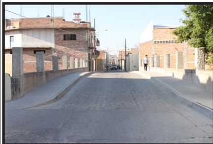
Trabajamos en la remodelación del puente en la calle Jesús Delgado y colocamos 155.77 metros cuadrados de empedrado ahogado en cemento, construimos la banqueta y levantamos los muros para colocar luminarias. Estos trabajos se realizaron por fondos de apoyo municipal con la cantidad de 457 mil 227 pesos.
